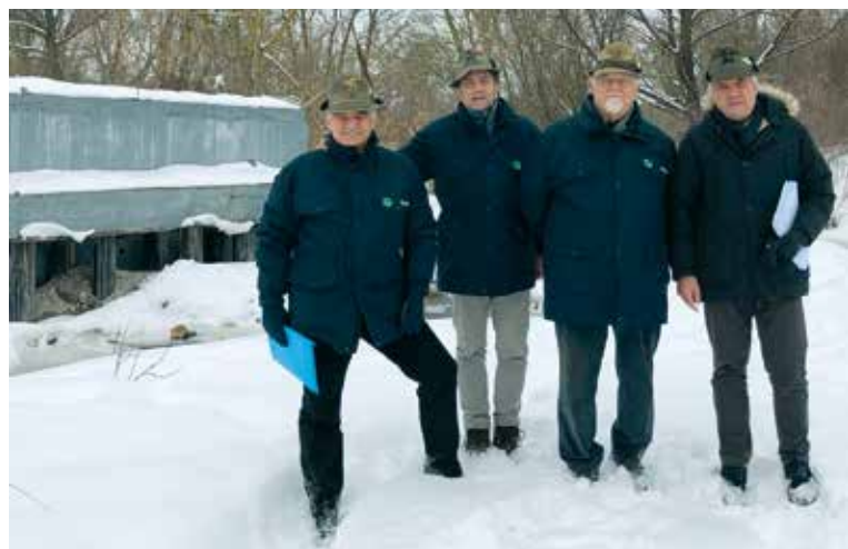
La delegazione dell’Ana in visita al cantiere dove sorgerà il ponte. In secondo piano si scorge uno dei muri d’ala in cemento armato, a sostegno della struttura.
