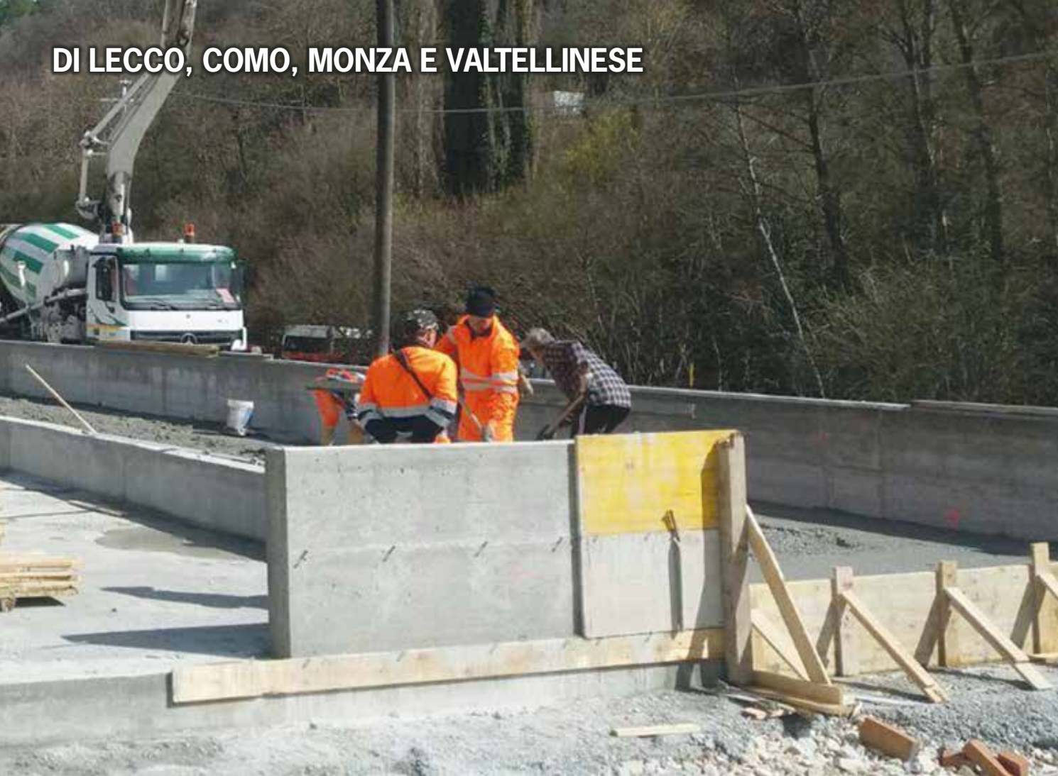
Il cantiere di Visso.
